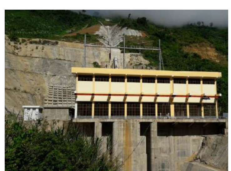
THỦY ĐIỆN SÔNG BUNG 2
