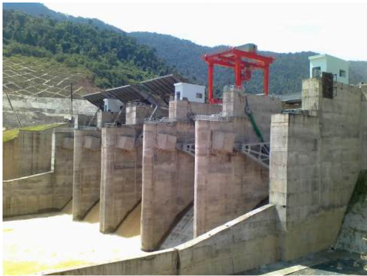
THỦY ĐIỆN SÔNG BUNG 4
